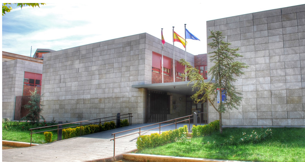
Nuevo edificio del CEIP Ferroviario inaugurado en el año 2004.
